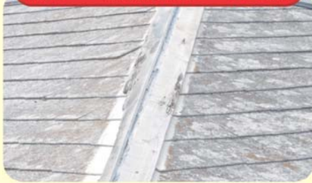
棟カバーの破損(スレート屋根)
